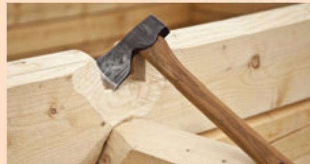
Сделайте брус и подготовьте его к постройке сруба, отфрезеровав его с обеих сторон нашим Логофрезом. Используйте топор или бензопилу для изготовления узлов/замков соединения единиц бруса между собой. Начните с баньки и закончите серьезным срубом.
